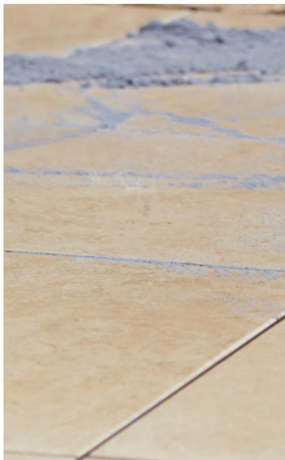
Разработанный специально для плит из керамогранита раствор для заполнения швов PFK поддерживает рост популярности керамических покрытий при обустройстве садов. Отличительной особенностью раствора является входящий в его состав цветной кварцевый песок очень мелкой зернистости. Цвета раствора песочный, бетонно-серый, сланец и черный превосходно дополняют безупречный внешний вид керамики. К тому же
