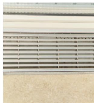
Деформационный шов между дренажным желобом и покрытием. С помощью посыпки поверхности кварцевым песком можно придать ей необходимые цвет и структуру.
