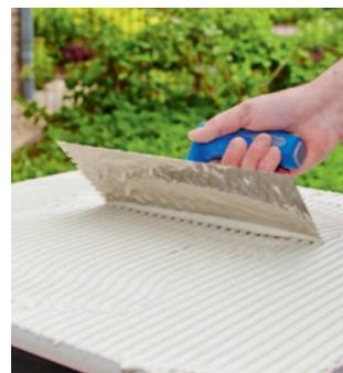
Для оптимального сцепления между керамическим элементом и раствором для подстилающего слоя на плитку зубчатым шпателем с шириной зуба 6 мм наносят раствор-шлам для повышения адгезии, например, трассовый раствор-шлам TNH-flex от tubag
