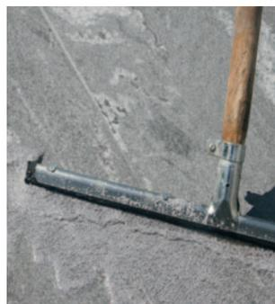
Раствор для заполнения швов брусчатки РФК зашламывают как и обычный песок для заполнения швов с большим количеством воды. Благодаря мелкой зернистости песка можно заполнять швы шириной от 2 мм.
