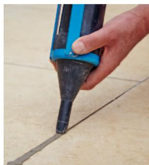
Водопроницаемый раствор для заполнения швов брусчатки РФК можно наносить зашламованием или вводить непосредственно в швы с помощью специальных шприцев.
